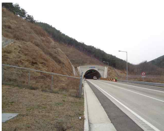
3공구 견달산터널(문산) 시점부
