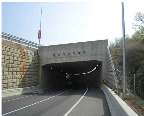
1공구 봉대산지하차도 종점부
