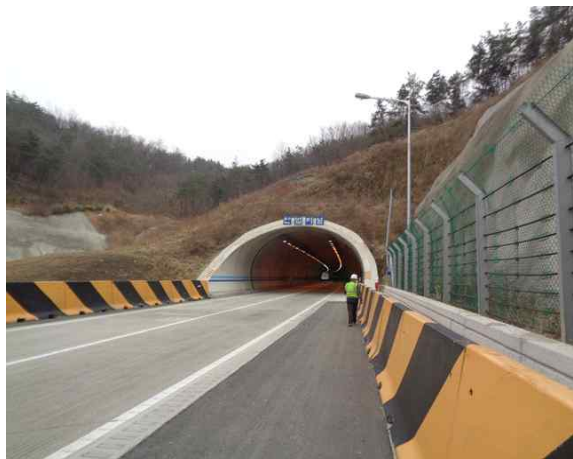
1공구 성라산터널(문산) 시점부
