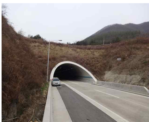
1공구 봉대산터널(문산) 종점부
