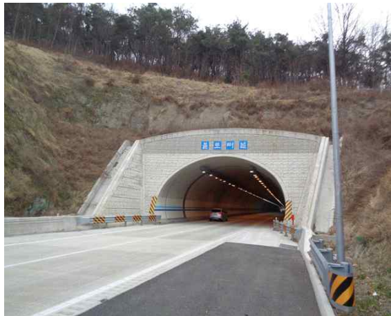
4공구 금촌터널(서울) 종점부
