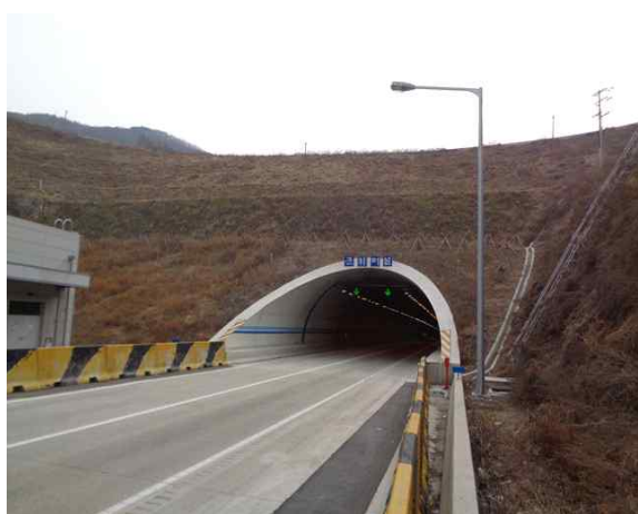
1공구 봉대산터널(문산) 시점부
