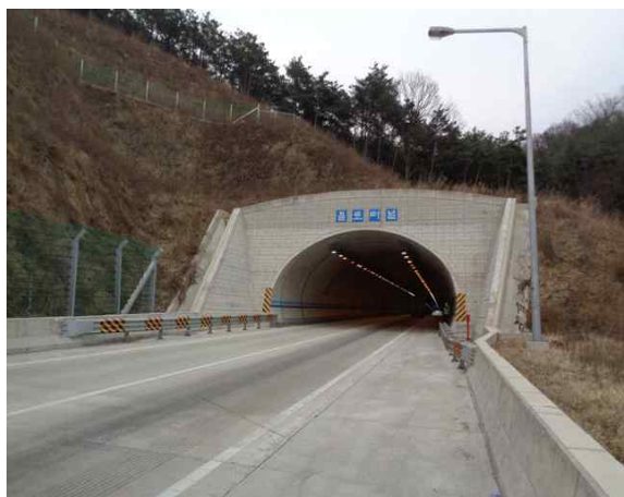
4공구 금촌터널(문산) 시점부
