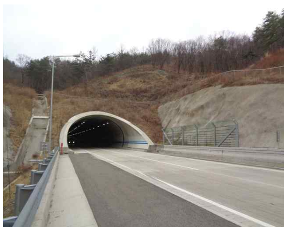
1공구 성라산터널(서울) 시점부
