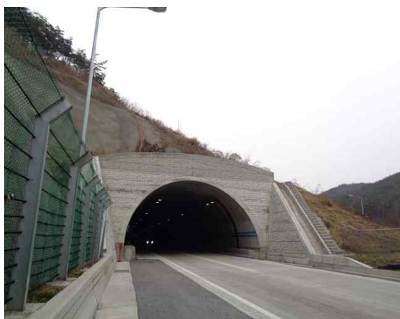
3공구 견달산터널(서울) 시점부
