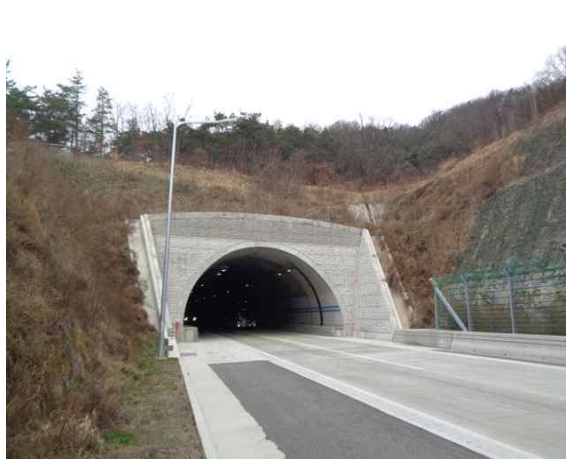
3공구 견달산터널(문산) 종점부
