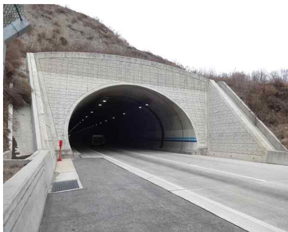
4공구 금촌터널(문산) 종점부
