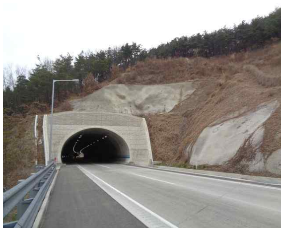
1공구 성라산터널(문산) 종점부
