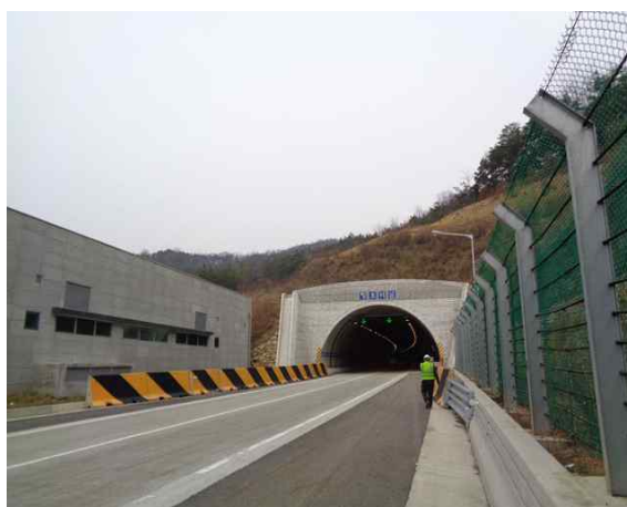
3공구 견달산터널(서울) 종점부
